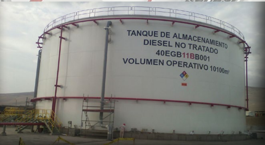
Herstellung von Kühlringen und Schaumstoff für den Schutz von Kraftstofftanks..
