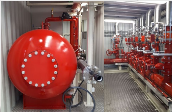
Vannes de déluge avec contrôle TRIM. Centre de mélange de mousse.
