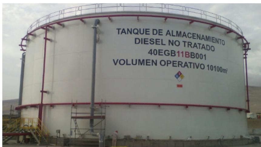
Fabricación de anillos de refrigeración y de espuma para protección de tanques de Combustible.
