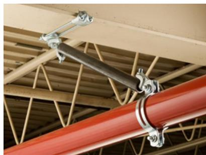
Soporte sismorresistente lateral de sujeción rápida.
