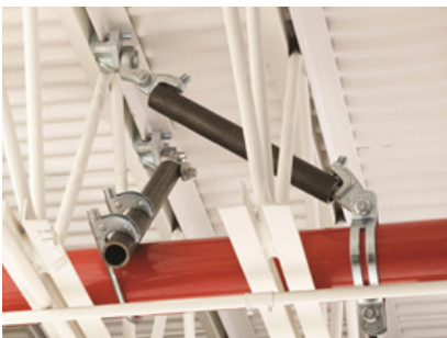
Fijador a viga tipo Joist.
