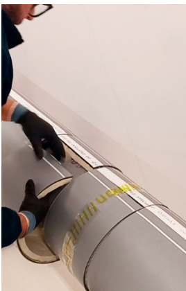
Colocamos la coquilla PUR (Kit de aislamiento) alrededor del tubo.
