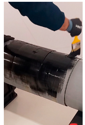
Aplicar una capa de imprimación uniforme (200ml/m 2 ) en la zona a cubrir.
