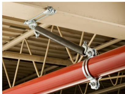
Fijador a viga tipo ajustable.
