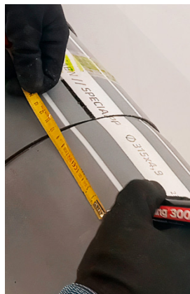
Marcamos la tubería externa entre 100 y 50 mm para ubicar el primer devanado.
