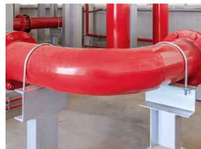
Soporteria doble para sujeción en abarcón sobre UPN formando una T para tubo curvado.
