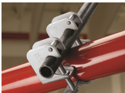
Soporte sismorresistente lateral de sujeción rápida.
